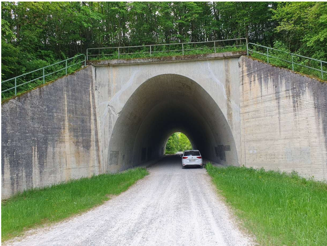
Ansicht von Norden auf das Bestandsbauwerk
